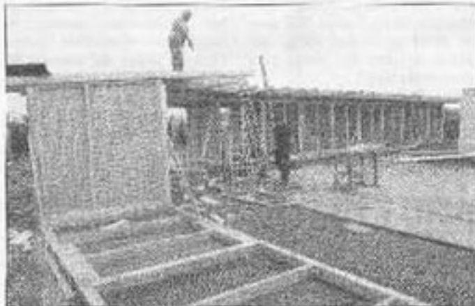
Die Bauarbeiten haben begonnen. FOTO: camera900.de
